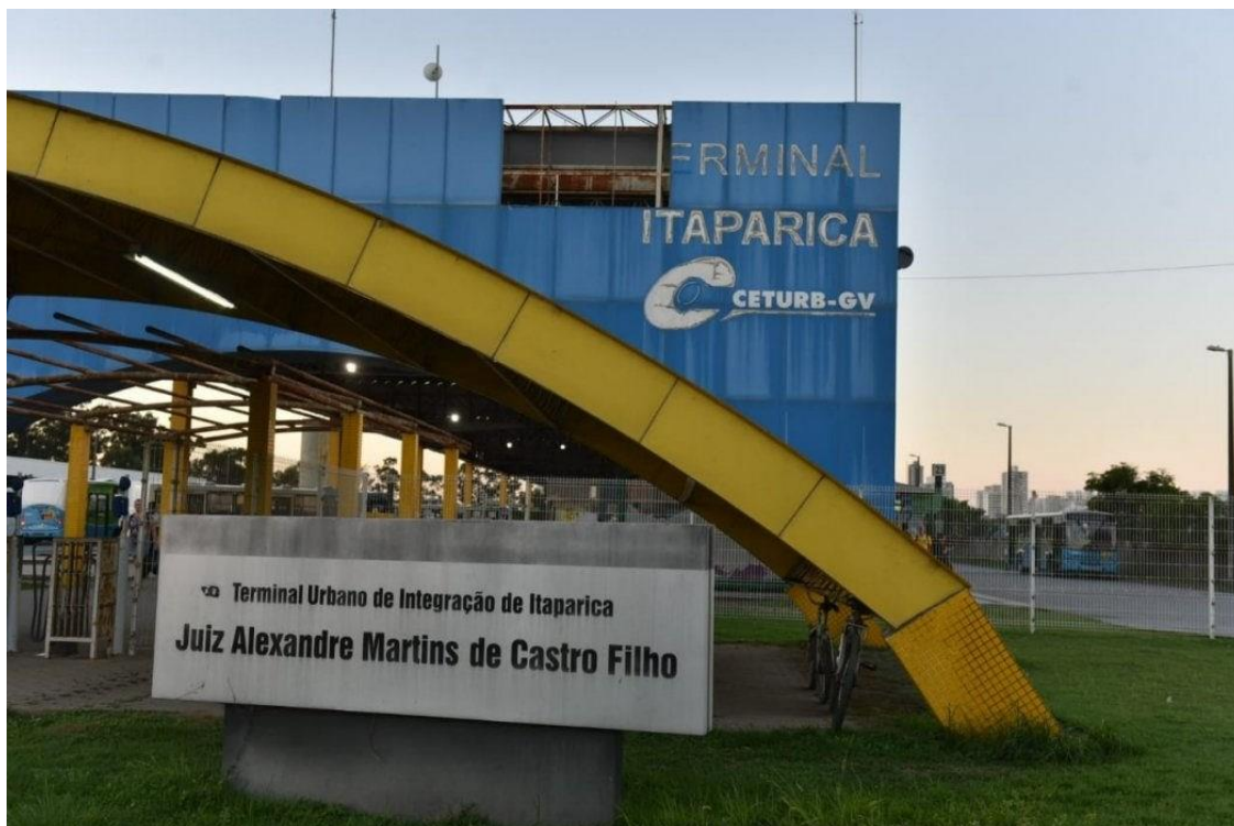
Imagem 01: Deslocamento do sistema de vedação da fachada principal do Terminal de Itaparica.
