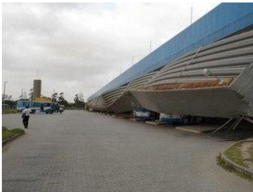
Imagem 01: Marquise oeste do Terminal de Itaparica em 06 de maio de 2013.( Fonte: Helyson Nery 1 ).
